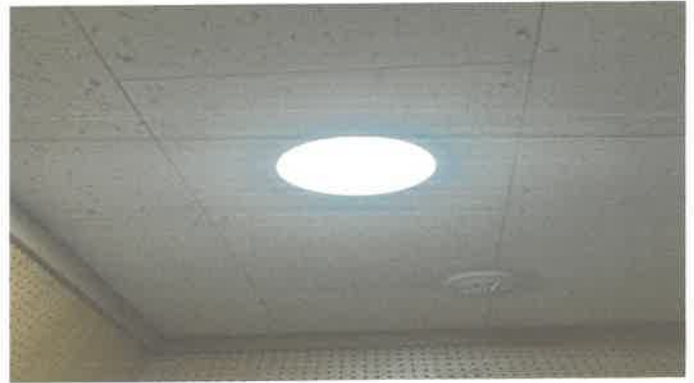
3층 드럼연습실 매입등 교체
