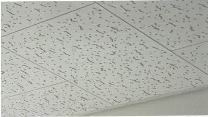
3층 드럼연습실 앞 천장텍스 교체
