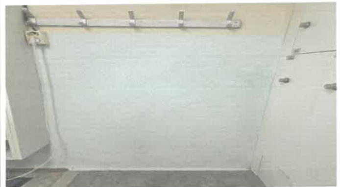
수영장 남자탈의실 부분 도색
